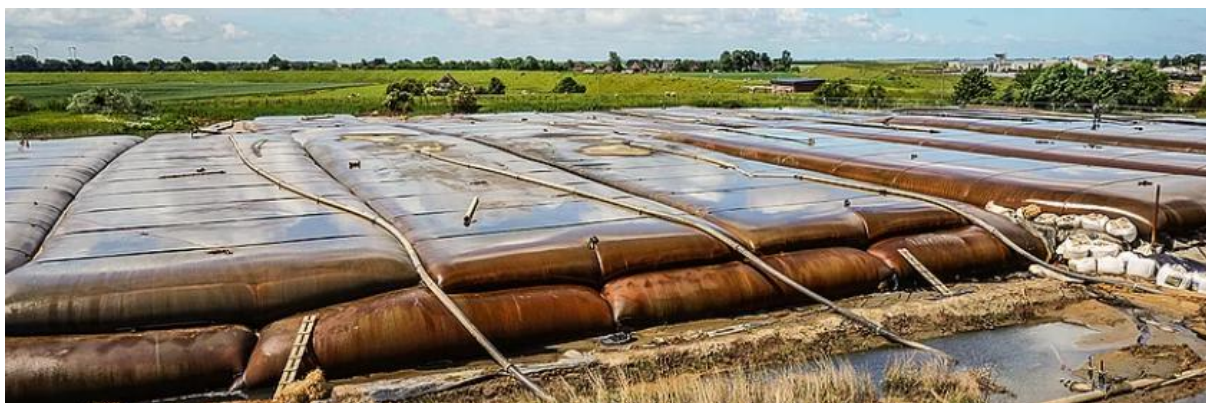
Slika 3-18: Primjer geotekstilnih vreća za dehidraciju sedimenta
