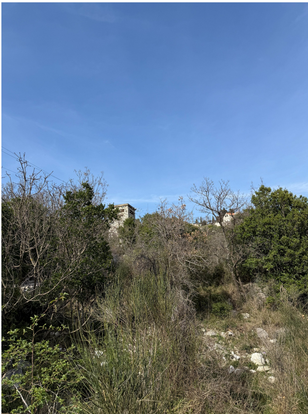
Slika 1.1 - 4 Prikaz postojećeg stanja – EE vod i trafostanica (Izvor: Idejno rješenje , travanj 2026.)
