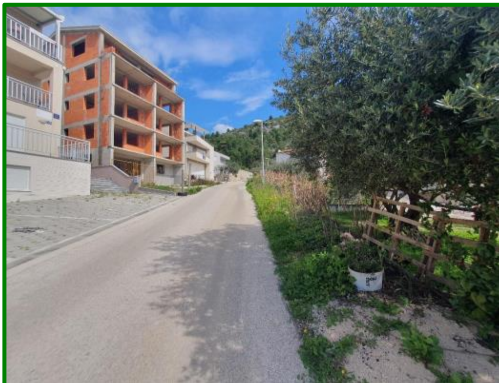
Slika 6. Dio planirane dionice – Postojeća prometnica na kojoj će biti izmješteno korito vodotoka
