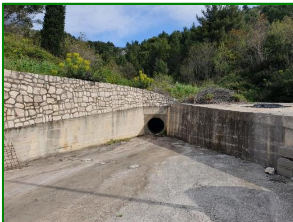
Slika 4. Uzvodna (uređena) dionica – završetak zacjevljenog dijela vodotoka i trapezno proširenje
