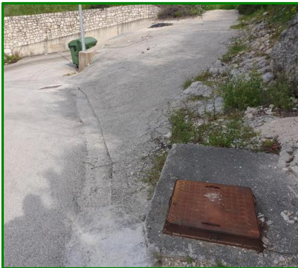
Slika 5. Uzvodna (uređena) dionica – Trapezno proširenje i okno regionalnog vodovoda Neretva-Pelješac-Korčula
