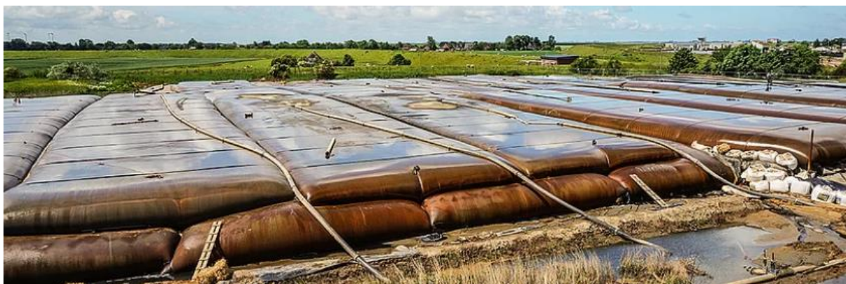
Slika 3-18: Primjer geotekstilnih vreća za dehidraciju sedimenta
