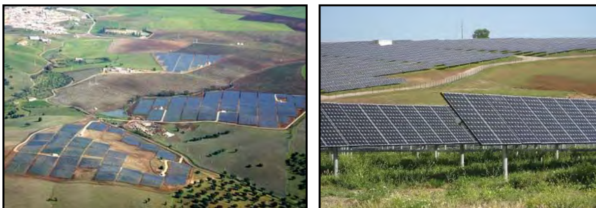
Slika 11. FN solarna elektrana Serpa (kraj Lisabona u Portugalu), instalirane snage 11 MW i godišnje proizvodnje veće od 18 GWh
