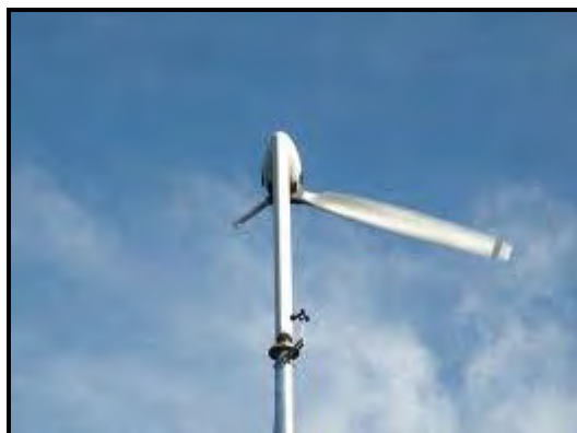
Slika 15. Vjetroagregat s jednom lopaticom
