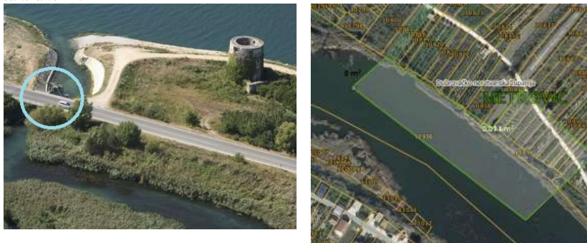
Slika 63: Ustava i most na ulazu u rukavac donje Stare Neretve i katastarske čestice u obuhvatu planirane LNT
