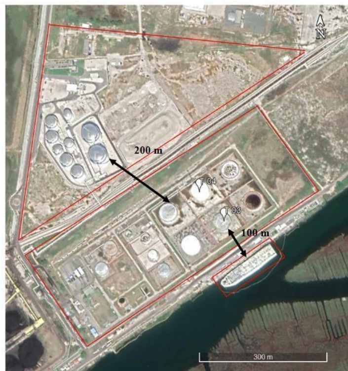
Slika 1. Udaljenost spremnika na području postrojenja od najbližih spremnika opasnih tvari susjednog postrojenja
